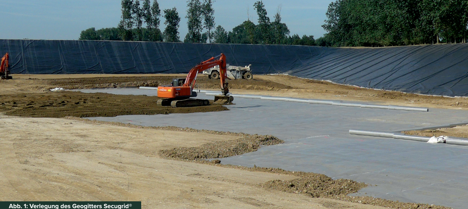
Abb. 1: Verlegung des Geogitters Secugrid®
