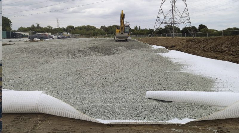
Fig. 2: Instalarea materialului granular pentru fundație
