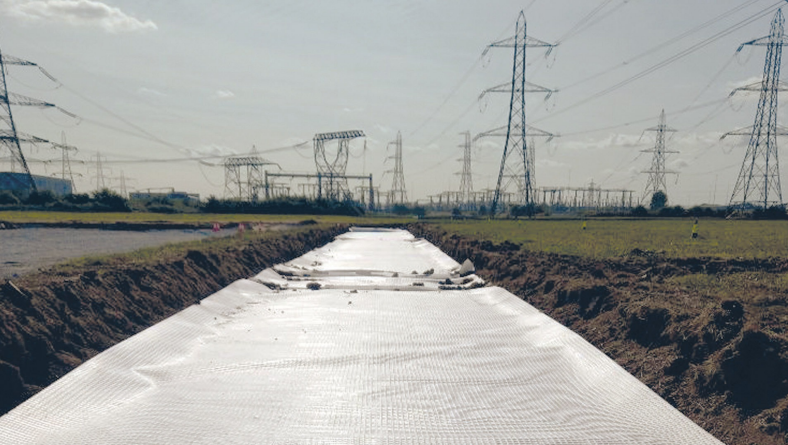
Fig. 1: Combigrid® instalat pe întreaga lungime
