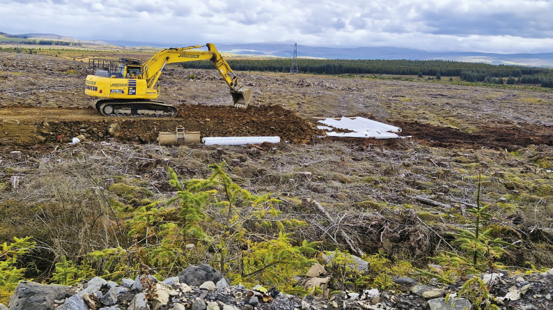
Fig. 1: Instalarea stratului de fundare
