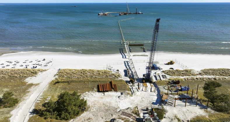
Afb.1: Bouw van de pier
