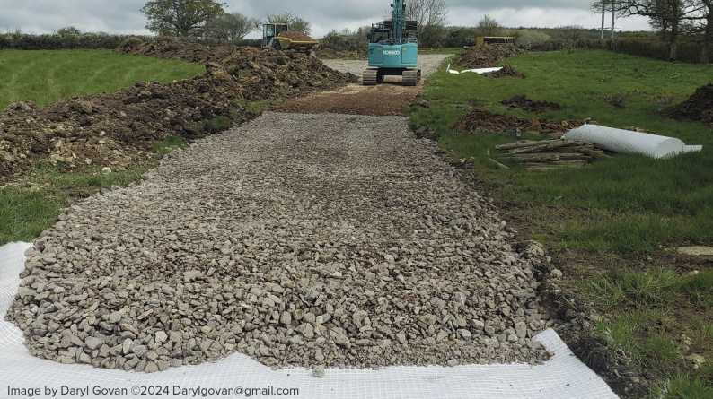
Fig. 2: Installatie van funderingsmateriaal bovenop Combigrid® (toegangsweg)
