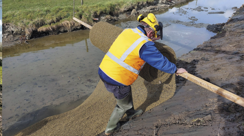
2. ábra: Secumat® Green 60G5 telepítése a töltéssel párhuzamosan
