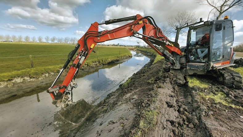
1. ábra: A töltés előkészítése
