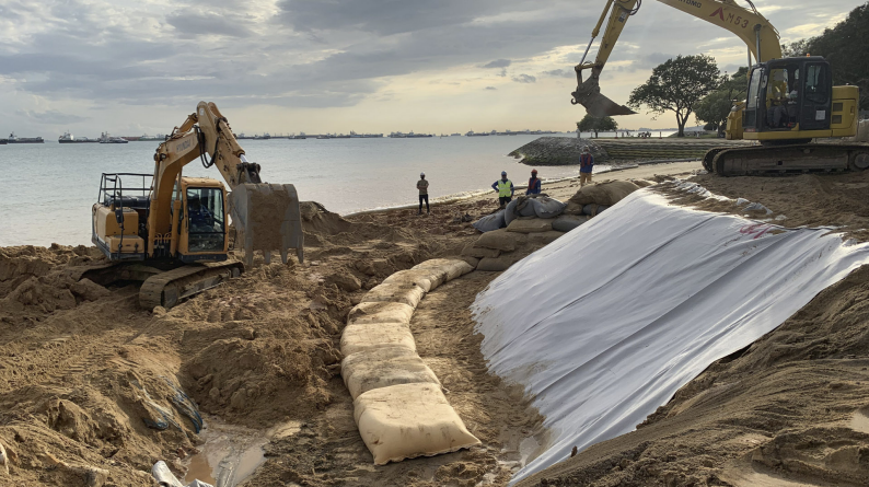
2. ábra: Secutex® Soft Rock beépítése
