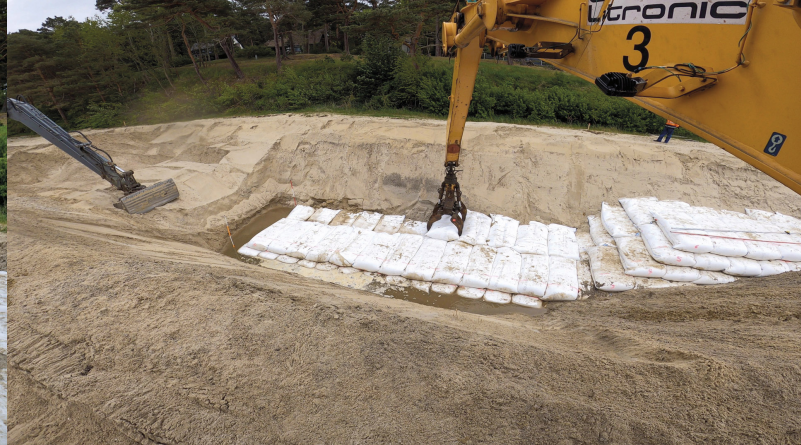
2. ábra: A geotextíliás homoktartályok beépítése
