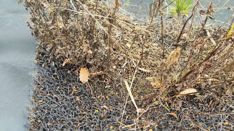
1. ábra: Eróziógátló szőnyeg növényzettel borítva
