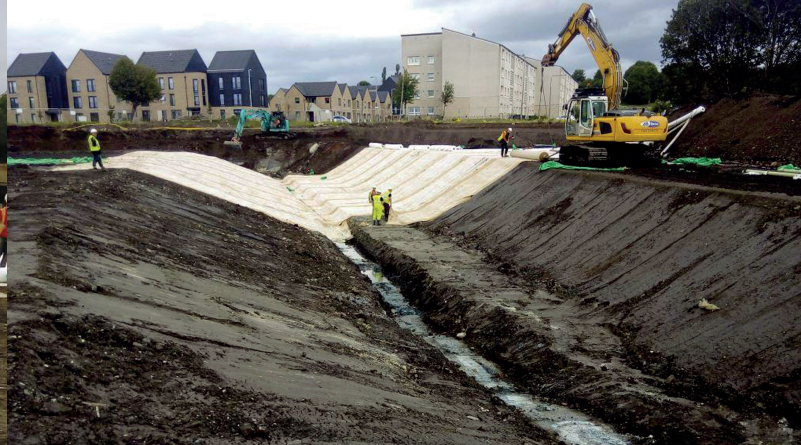
2. ábra: Bentofix® GCL beépítése a zagfalon keresztül
