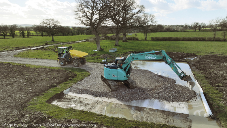
Fig. 1 : Mise en place du matériau de la couche de base sur Combigrid®.
