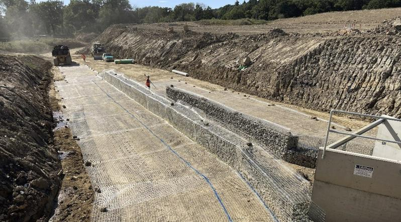
Fig. 1 : Installation de Naue Secugrid®.
