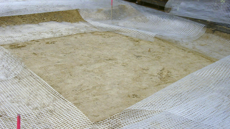
Fig. 1 : Installation multicouche de Secugrid® autour de la section de surveillance
