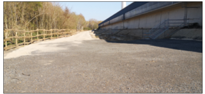
Fig. 2 : Voie de chantier provisoire prête à l'exploitation
