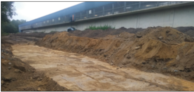
Fig. 1 : Terrain préparé pour la construction d'une voie de chantier provisoire
