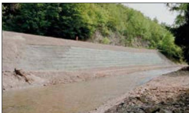
Fig. 5 : Solution de réhabilitation au moyen d'une structure en sol renforcé par les géogrilles Secugrid®
