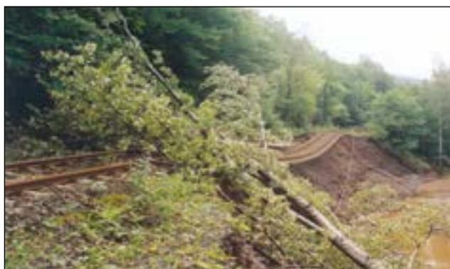
Fig. 4 : Voie ferrée de Weesenstein, 2002, dommages liés à l'érosion
