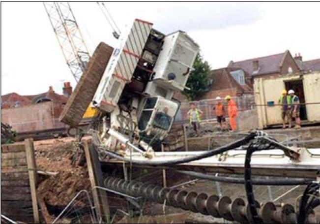
Figure 2 : Exemple d'un accident de plate-forme de forage (quai d'Emsworth, Australie, juillet 2019)
