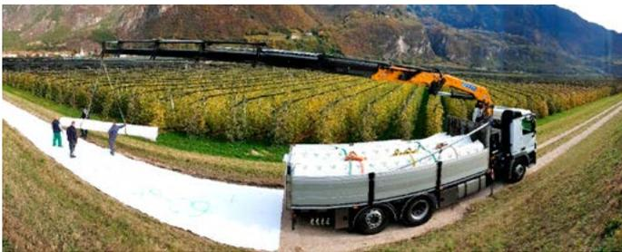
Géotextile biodégradable pour routes d'accès chantier et pistes provisoires
