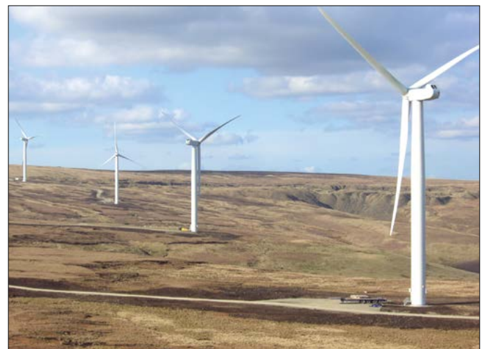
Fig. 4 Phase finale du parc éolien avec des zones renforcées avec Secugrid®
