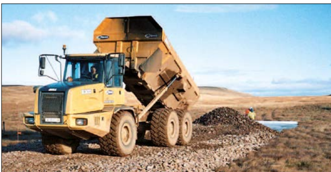
Fig. 3 Mise en œuvre du remblai sur Secugrid® de Naue
