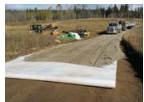
Figure 7 : Mise en œuvre du Combigrid®
