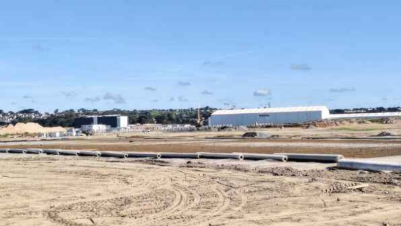
Pic. 1 : Installation de Secugrid®, recouverte de sable
