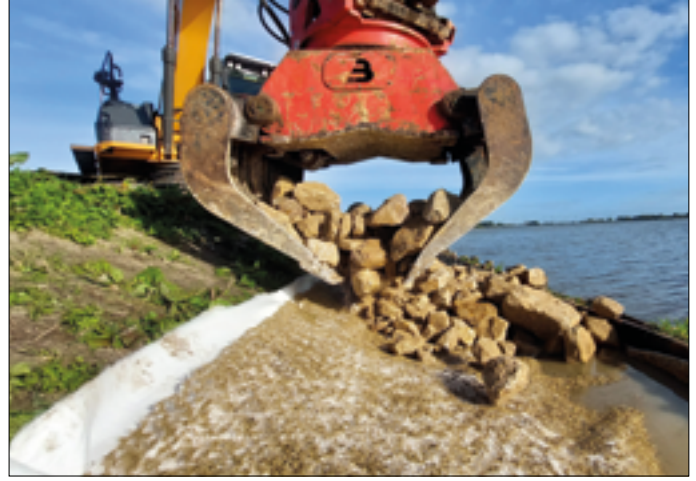
Abbildung 7: Secumat® Green Wirrgelege am Binnenmeer (Wasserseite)
