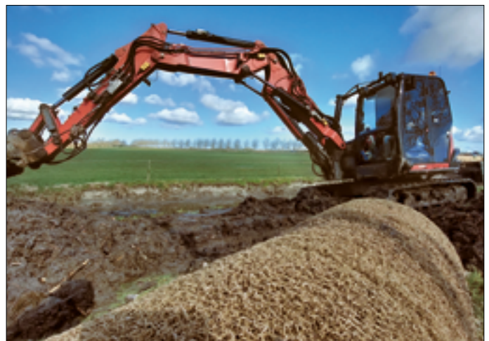
Abbildung 9: Einbau Secumat® Green Wirrgelege
