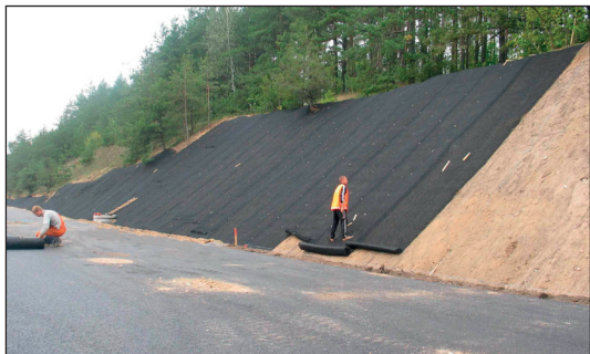
Abb. 3: Straßenböschung mit Secumat® Wirrgelege
