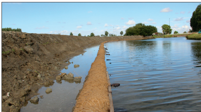
Abb. 3 Geowalze am Gewässerufer
