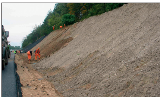
Abb. 2: Planumserstellung der Straßenböschung
