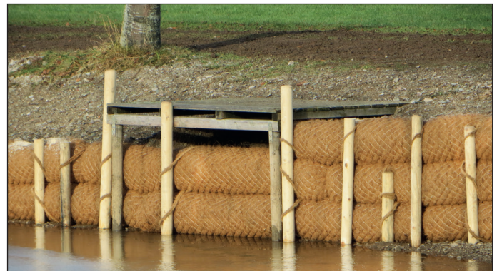
Abb. 4 Gestapelte Geowalze am Prallufer eines Gerinnes
