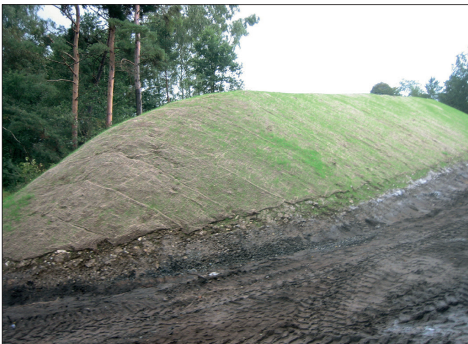
Abbildung 8: Jutenetz auf einer Böschung
