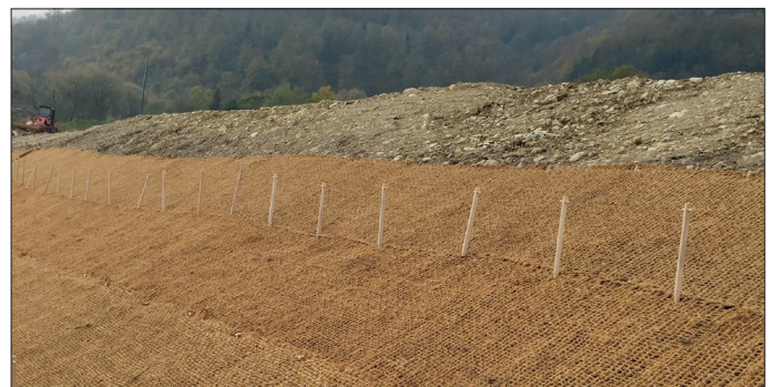
Abbildung 5: Einbau des Erosionsschutzsystems
