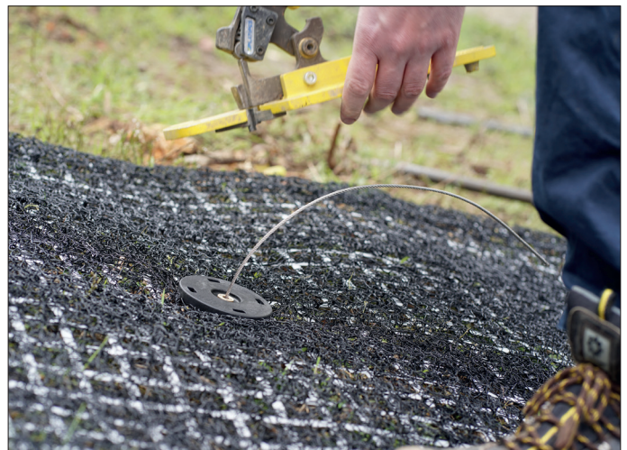
Abbildung 5: Erdanker verriegeln und anziehen
