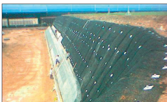
Abb. 2: Einbau des Naue Nail Systems
