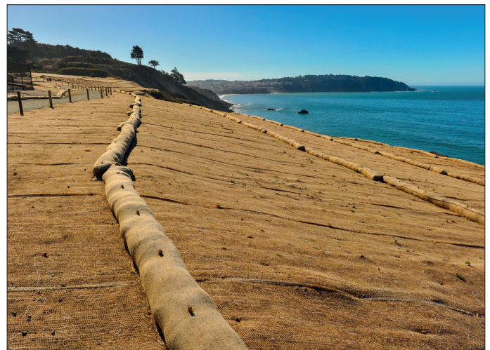
Abbildung 9: Geowalze parallel zur Böschung
