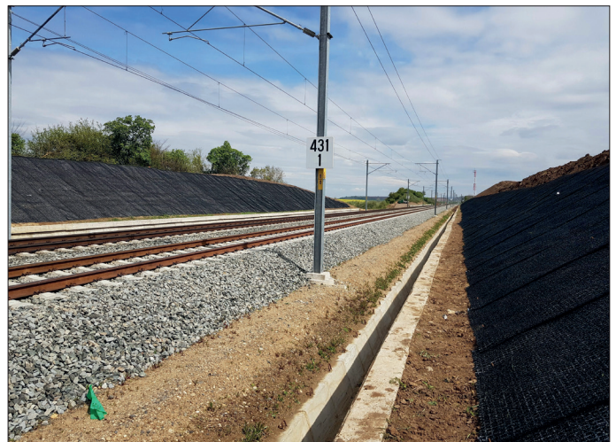
Abbildung 22: Bahndamm mit Wirrgelege
