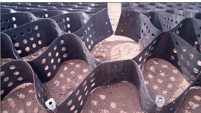
Abb. 10 Anschließen einer weiteren Sektion
