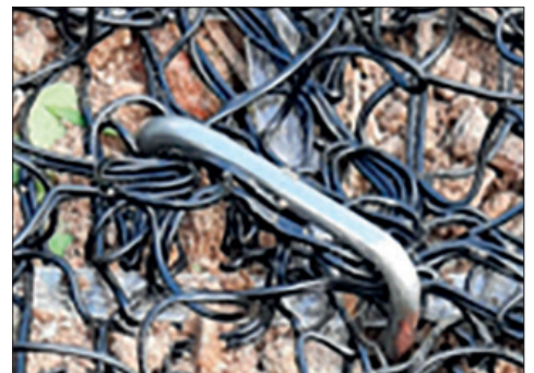
Abbildung 5: Drahtbügel befestigt das Wirrgelege
