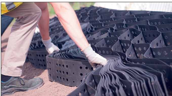
Abb. 7 Verlegen der Geozellensektion hangabwärts
