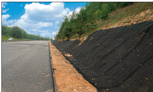
Abb. 3: Straßenböschung mit Erosionsschutzsystem
