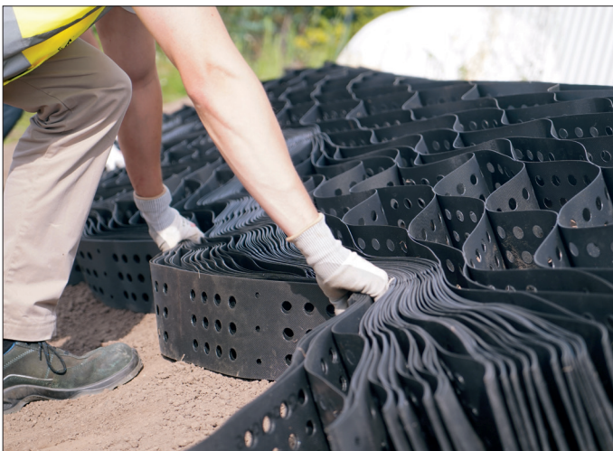
Abbildung 9: Aufbau der Secumat® Cell 150 an einer Böschung
