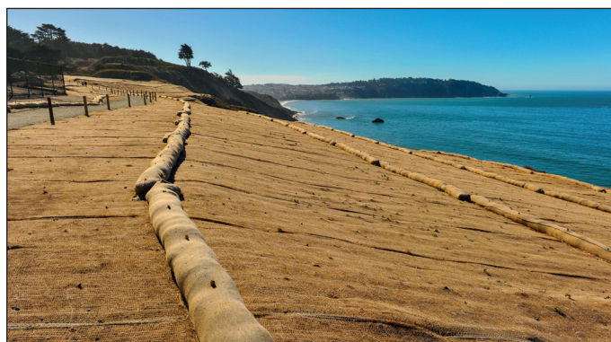
Abb. 5 Geowalze auf einer Böschung
