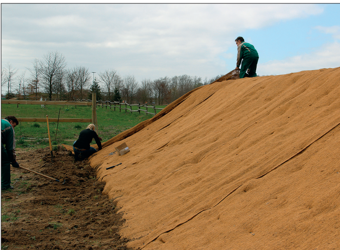
Abbildung 8: Kokosmatte auf einer Böschung
