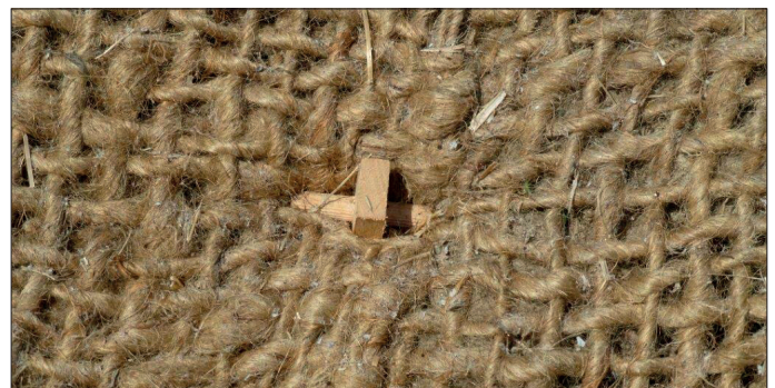
Abbildung 5: Jutenetz mit Holzpflock
