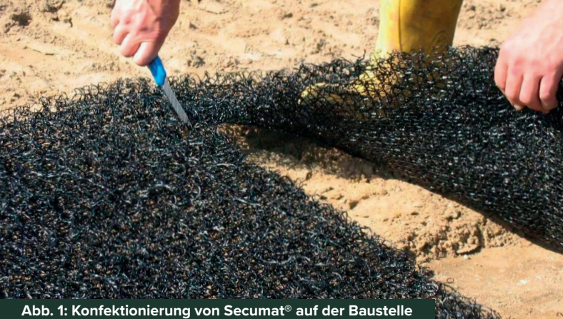
Abb. 1: Konfektionierung von Secumat® auf der Baustelle
