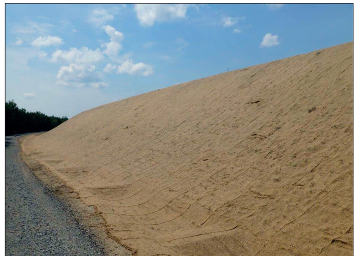
Abbildung 9: Jutenetz als Straßenerosionsschutz
