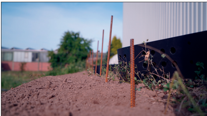
Abb. 6 Vormontierte Befestigungen an der Böschungskrone
