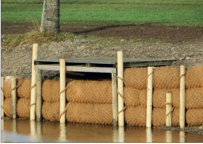
Abbildung 6: Gestapelte Geowalzen auf Uferrand mit Holzpfählen
