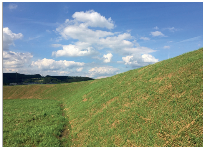
Abbildung 9: Kokosnetz auf der Böschung
