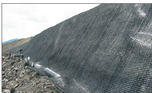
Abb. 2: Aufbau des Naue Clamp Systems
