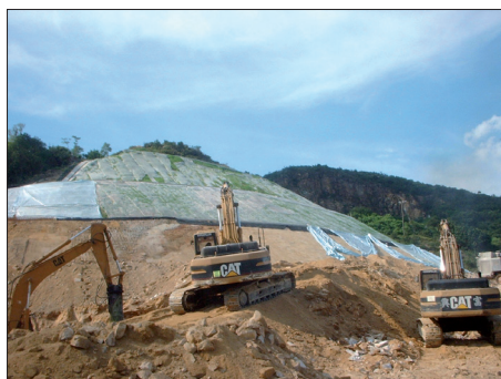
Abbildung 5: Böschungssicherung im Bau
