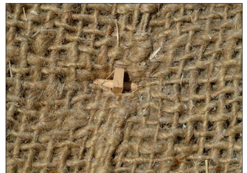
Abbildung 5: Holzpflöck mit Jutenetz
