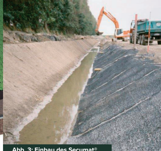
Abb. 3: Einbau des Secumat® Erosionsschutzsystems
