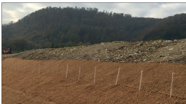
Abbildung 4: Holzpflöck mit Kokosnetz
