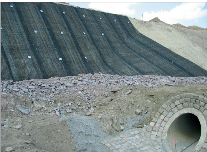
Abbildung 21: Steilböschung mit Wirrgelege
