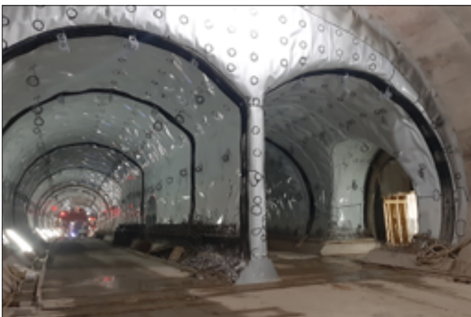
Carbofol® Tunnelabdichtung mit Carbofol® ME-Anker
