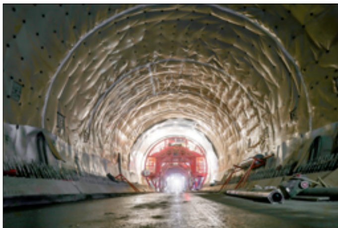
Bentofix® X-Type im Gewölbebereich
