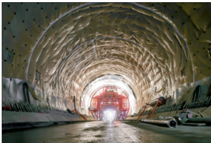
Bentofix® X-Type im Gewölbebereich
