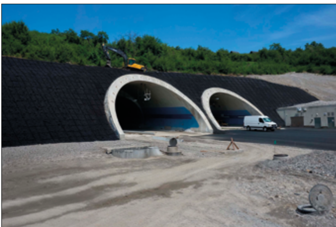
Secumat® Erosionsschutz an Tunnelböschungen
