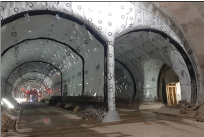
Carbofol® Tunnelabdichtung mit Carbofol® ME-Anker
