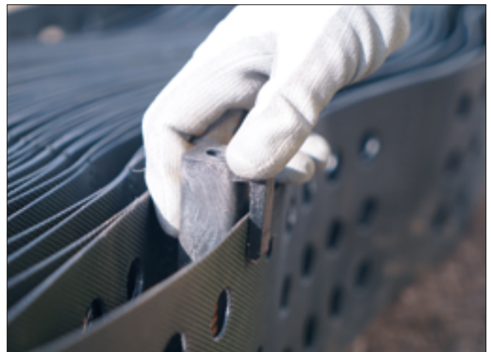
Abbildung 10: Einsetzen der Secumat® PinCap
