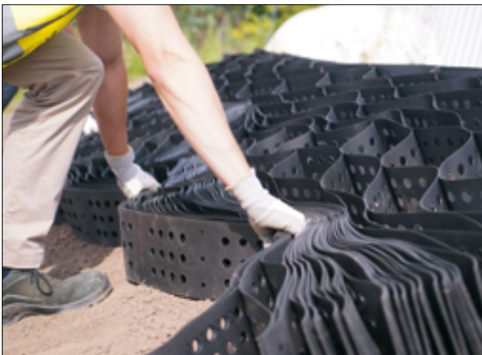
Abbildung 9: Aufbau der Secumat® Cell 150 an einer Böschung
