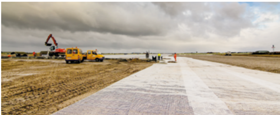
Abbildung 5: Großflächiger Einbau eines Secugrid® Geogitters zur Tragschichtbewehrung
