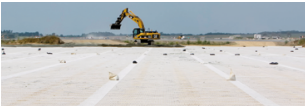
Abbildung 7: Beschüttung eines verlegten Secugrid® Geogitters in einer Tragschicht
