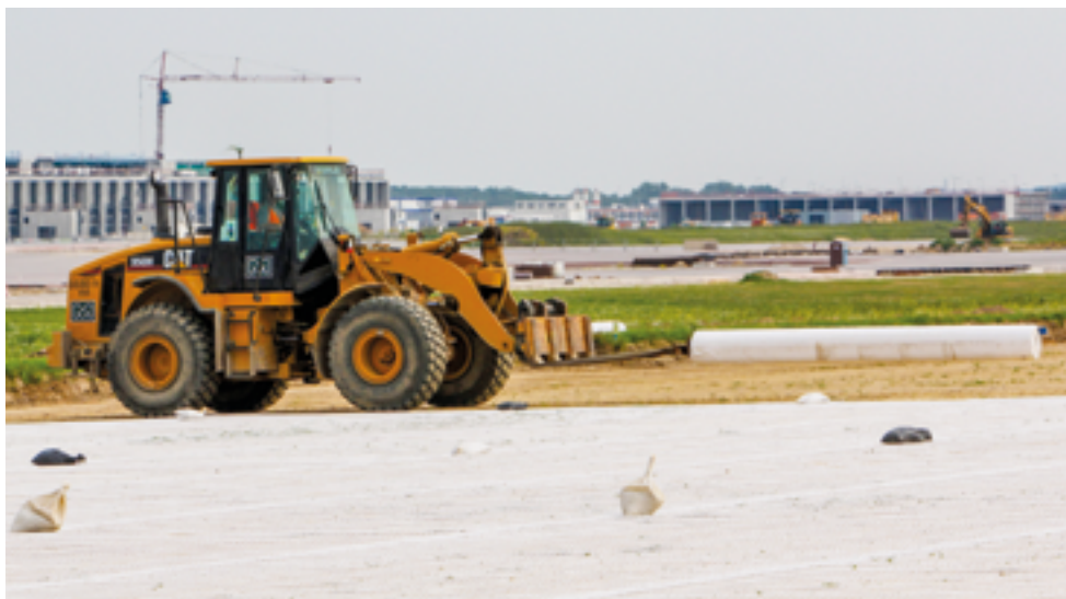
Abbildung 11: Verlegung von Secugrid® (keine Vorspannung nötig)
