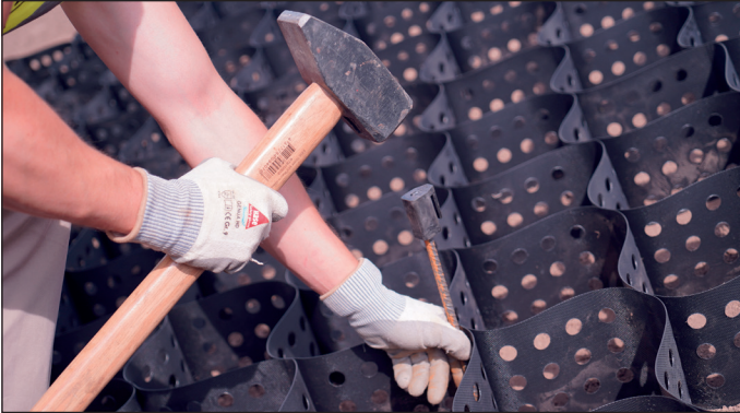
Abb. 8 Fixierung der Geozelle auf der Böschung
