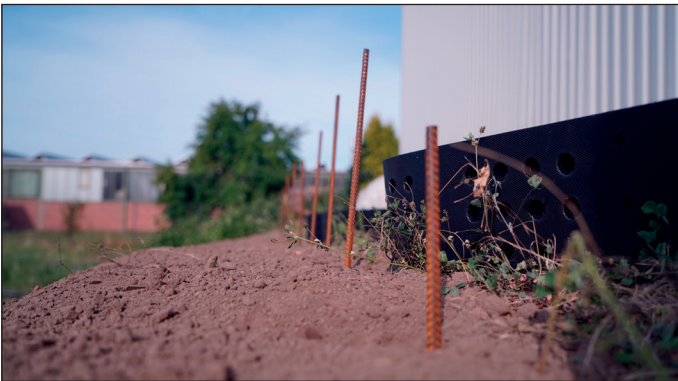
Abb. 6 Vormontierte Befestigungen an der Böschungskrone
