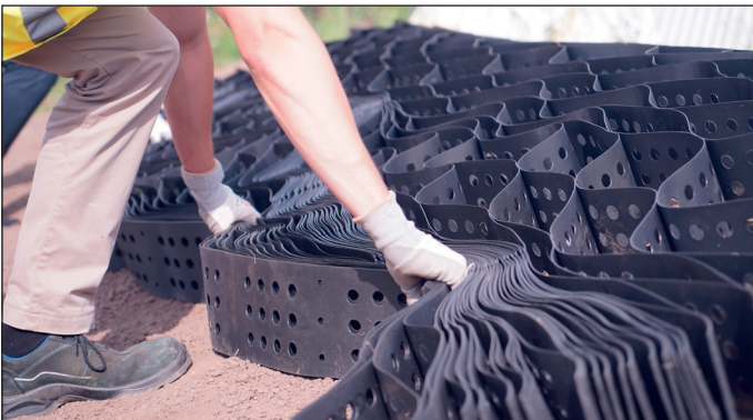
Abb. 7 Verlegen der Geozellensektion hangabwärts
