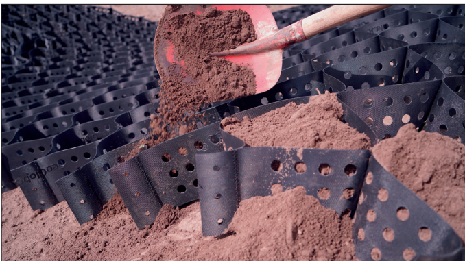
Abb. 9 Füllung der Geozelle
