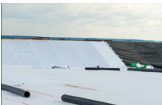
Abbildung 17: Secudrain® WD Dränlage an Regenrückhaltebecken
