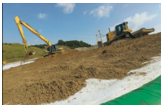
Abbildung 18: Secudrain® BAM auf einer Deponie zwischen Oberflächendichtung und Rekultivierungsschicht
