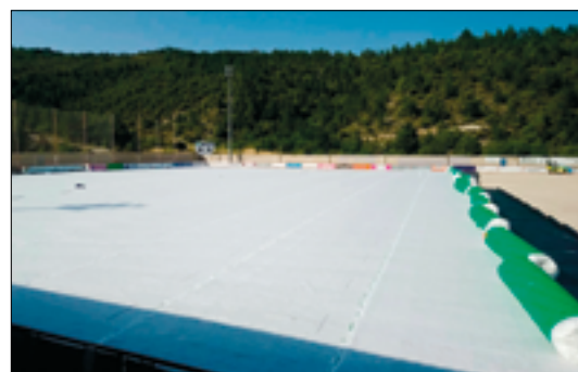
Abbildung 5: Secudrain® als Fußballfeld-Drainage
