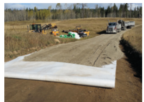
Abbildung 7: Einbau von Combigrid®
