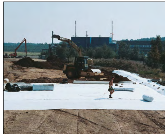
Bild 32 Bentofix® RiStWag Abdichtung beim Neubau der B 82n Ortsumgehung (Langelsheim/Astfeld)
