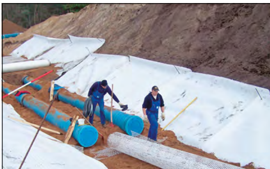
Bild 81 Combigrid® im Rohrleitungsgraben zur Tragfähigkeitserhöhung (Briesen)
