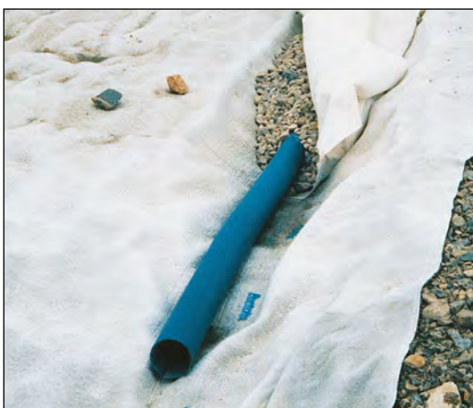
Bild 7 Die Kiespackung um den Regenwassersammler ist mit einem Secutex® Filtervliesstoff umhüllt, damit keine Feinanteile vom umgebenden Boden eingewaschen werden und den Sammler verstopfen
