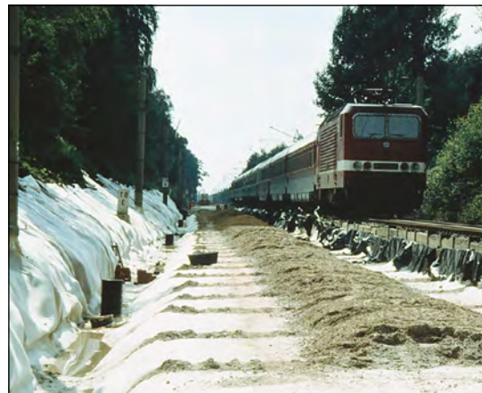
Bild 35 Einsatz von Bentofix® unterhalb einer Eisenbahntrasse (Dresden, Leipzig)
