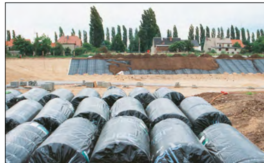
Bild 44 Einbau des Oberbodens in die Erosionsschutzmatte Secumat® (Regenrückhaltebecken, Köthen)
