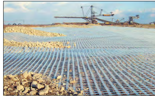
Bild 26 Beschüttung der Secugrid®- bewehrten Tragschicht
