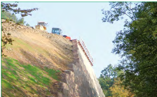
Bild 55 Secugrid® bewehrte Stützwandkonstruktion mit Gabionen
