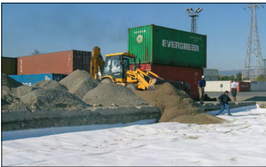
Bild 16 Combigrid® zur Erhöhung der Tragfähigkeit
