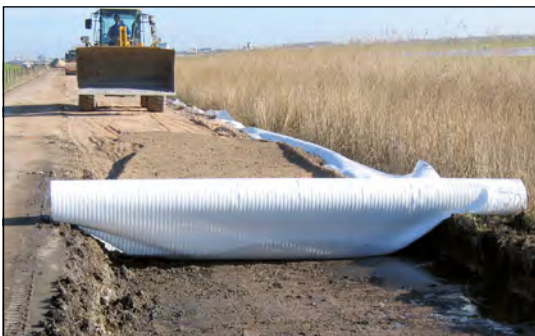
Bild 23 Einbau von Combigrid® zur Tragschichtverbesserung (Bremerhaven)
