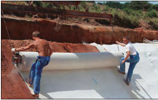
Bild 31 Traversenverlegung von Bentofix® im Randbereich einer Straße (B 70, WSBA Münster)
