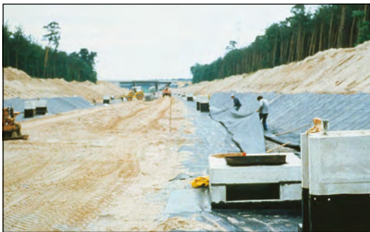
Bild 34 Verlegung von Carbofol® Kunststoffdichtungsbahnen mit Schachteinbauten in Wasserschutzgebieten
