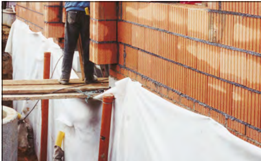
Bild 61 Secudrain® als Kellerwanddränage und gleichzeitige Schutzlage der Kellerwanddichtung
