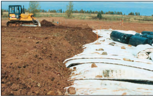
Bild 74 Einbau des Oberbodens oberhalb der Horizontalent- wässerung Secudrain®
