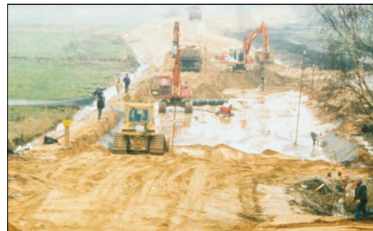
Bild 14 Einsatz von Secugrid® als Dammbewehrung (Loxstedt)
