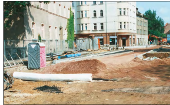
Bild 17 Einsatz von Secutex® im Straßenbau (Weißenfels)
