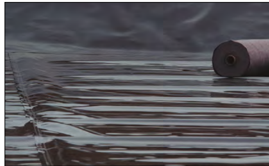
Bild 73 verschweißte Carbofol® Kunststoffdichtungsbahn (Allmannsweier, Deutschland)
