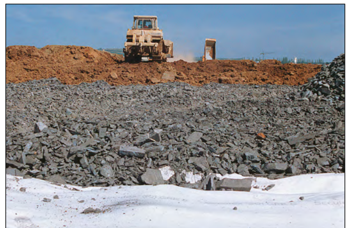
Bild 2 Die hohe Dehnbarkeit von Secutex® stellt die Widerstandsfähigkeit gegen Einbaubeschädigungen sicher
