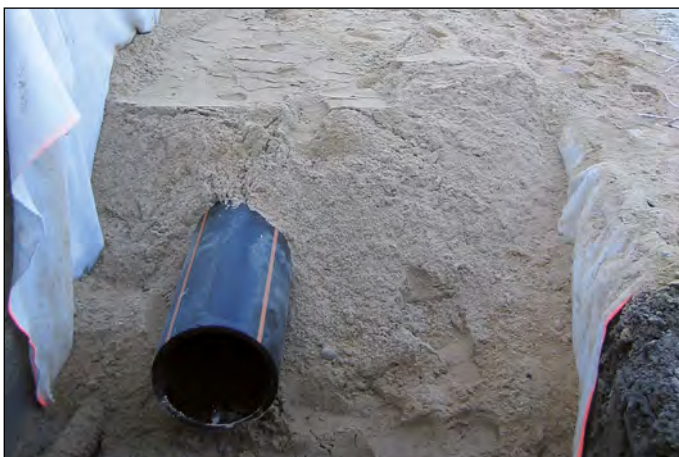
Bild 1 Secutex® Vliesstoff als Trennlage zwischen Rohrbettung und feinkörnigem Untergrund
