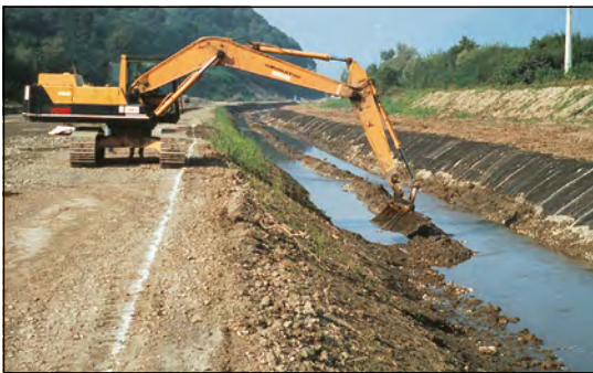
Bild 46 Befüllung der Erosionsschutzmatte in einem Regen- wassersammler (A43, Chalons - Albertville)
