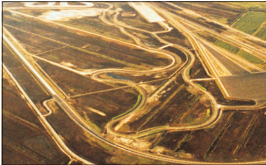
Bild 13 Trennen und Filtern mit Secutex® auf einer Automobil-Teststrecke (Papenburg)
