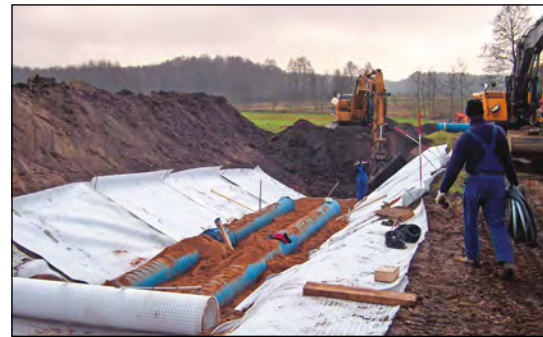
Bild 82 Einbau von Secugrid® über die verlegten Rohre als Bewehrung und gegebenenfalls als Signallage bei Aufgrabungen (Briesen)
