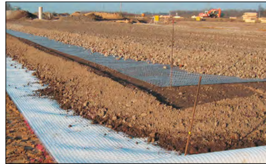
Bild 75 Zweilagige Secugrid® und Combigrid® Bewehrung eines Straßendamms, Bundesstraße bei Nordenham
