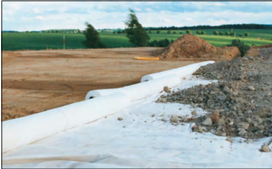
Bild 22 Secutex® als Trenngeotextil zwischen feinkörnigem Untergrund und grobkörnigem Schüttmaterial
