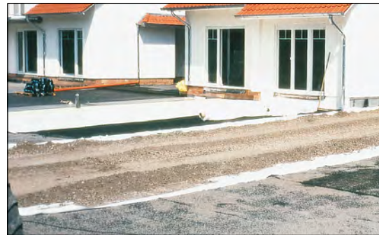
Bild 24 Trennen und Filtern mit Secutex® bei einer Garagenzufahrt (Gehlenbeck)
