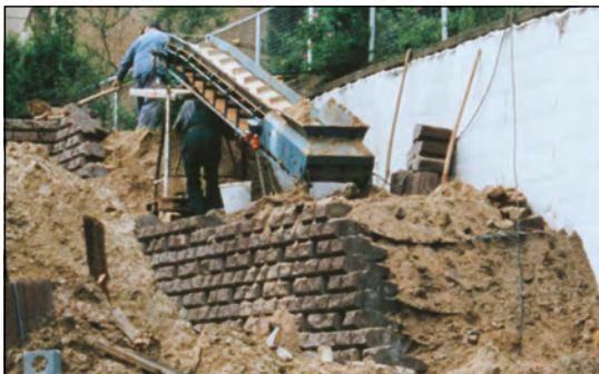
Bild 62 Bauwerkentwässerung mit Secudrain® hinter einer bewehrten Steilwand
