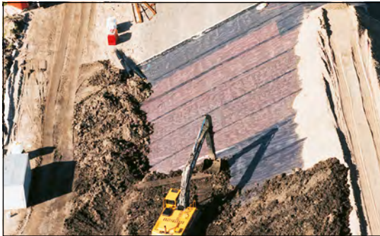
Bild 42 Secugrid® 120/40 R6 sichert die Böschungsstabilität beim Lärmschutzwall (A12, Niederlande)
