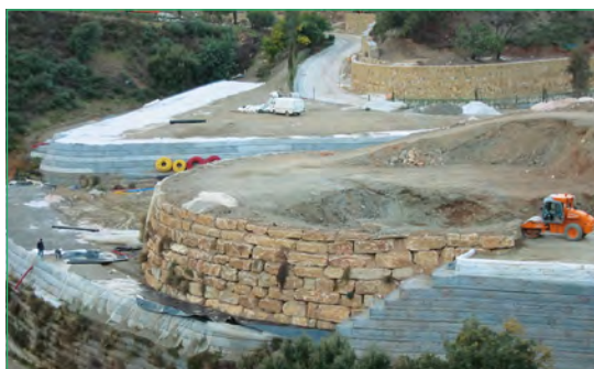
Bild 53 Bau einer Stützwandkonstruktion mit Secugrid® (Marbella Hill, Spanien)
