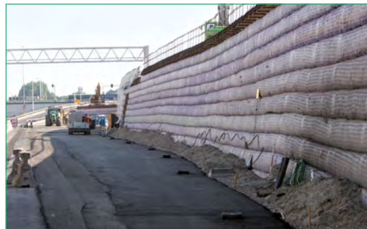
Bild 56 Bewehrte Böschung mit Secugrid® Geogittern, eingebaut im Umschlagverfahren
