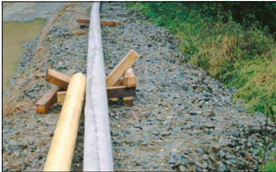
Bild 80 Schutzum- mantelung einer Rohrleitung mit Secutex® (Arnstorf)
