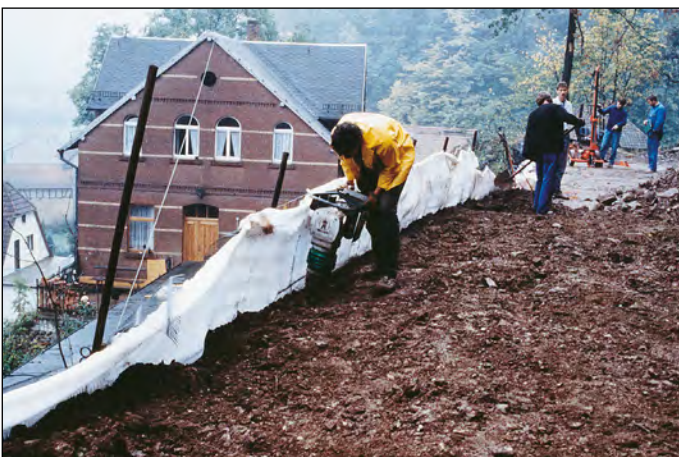
8 Bild 5 Der Secutex® Filtervliesstoff verhindert das Auswaschen von Bodenpartikeln einer Steilwand aus der Außenhaut
