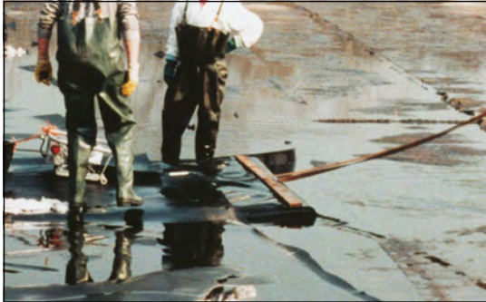
Bild 71 Verschweißen der gasdichten Carbofol® Abdeckung (Teersee, Rositz)
