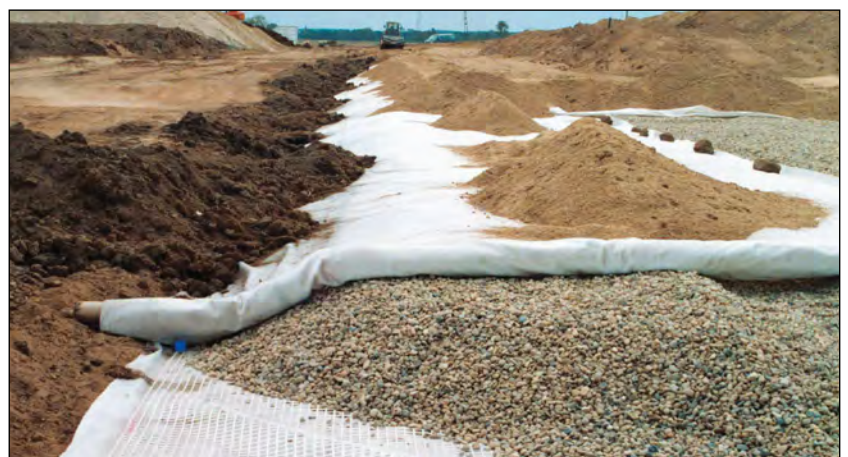
Bild 8 Secutex® trennt die Filterpackung vom umliegenden feinkörnigen Boden
