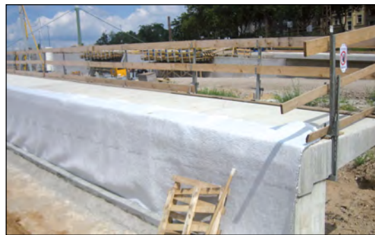
Bild 66 Einsatz von Secudrain® bei Brückenwiderlager („Le Quartier“, Düsseldorf)
