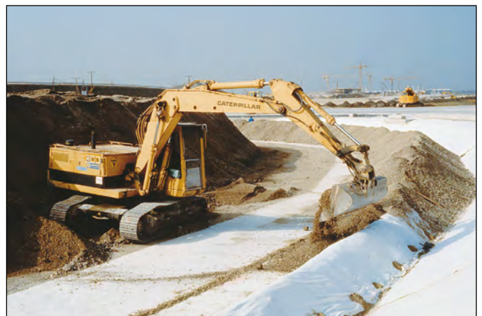
Bild 6 Secutex® Filtervliesstoffe verhindern das Einwaschen von Feinanteilen in den Filterdamm
