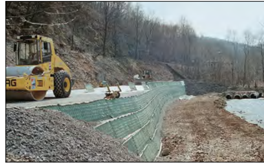
Bild 47 Böschungssicherung zur Behebung der Hochwasserschäden auf dem Weesen- steiner Abschnitt der Müglitztalbahn
