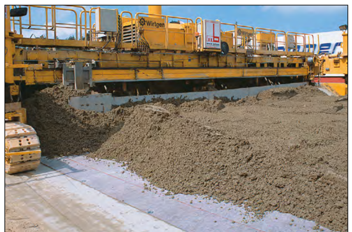
Bild 4 Einbau der Betondeckschicht über den Vliesstoff Secutex®, der gleichzeitig die Funktionen Trennen, Filtern und Dränen erfüllt
