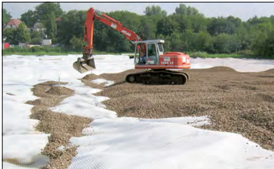
Bild 72 Combigrid® im Einsatz über einem extrem weichen Untergrund
