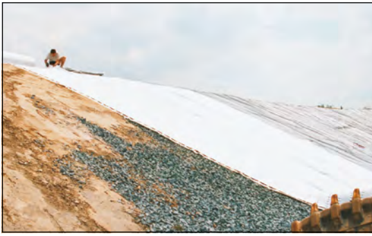
Bild 45 Böschungssicherung und Schichten- wassersammlung mit Secudrain®
