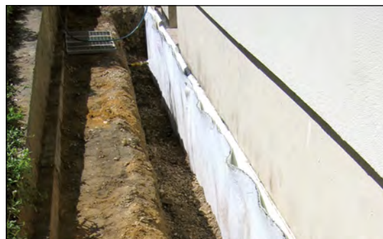
Bild 63 Hinterfüllung von Secudrain® im Kellerbereich
