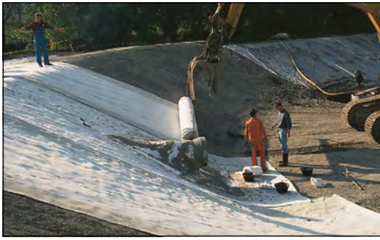
Bild 33 Einbau von Bentofix® in einem Regenrückhaltebecken
