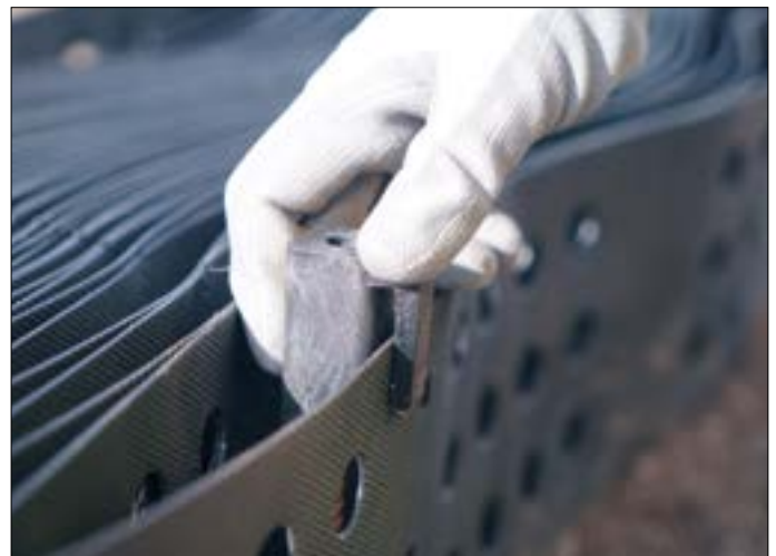
Abbildung 10: Einsetzen der Secumat® PinCap
