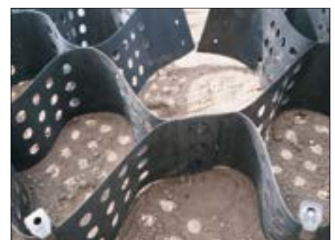
Abbildung 6: Große Geozelle Secumat® Cell 150 verschraubt mit Secumat® Screw und im Boden befestigt mit Secumat® PinCap
