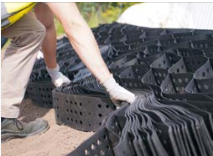
Abbildung 9: Aufbau der Secumat® Cell 150 an einer Böschung
