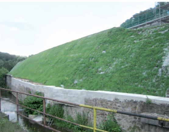
Die Systembewehrung Secugrid® PET wird nach bodenspezifischen Eigenschaften und statischen Erfordernissen nach DIN 1054:2005, DIN 4084 und EBGE0 bemessen.
