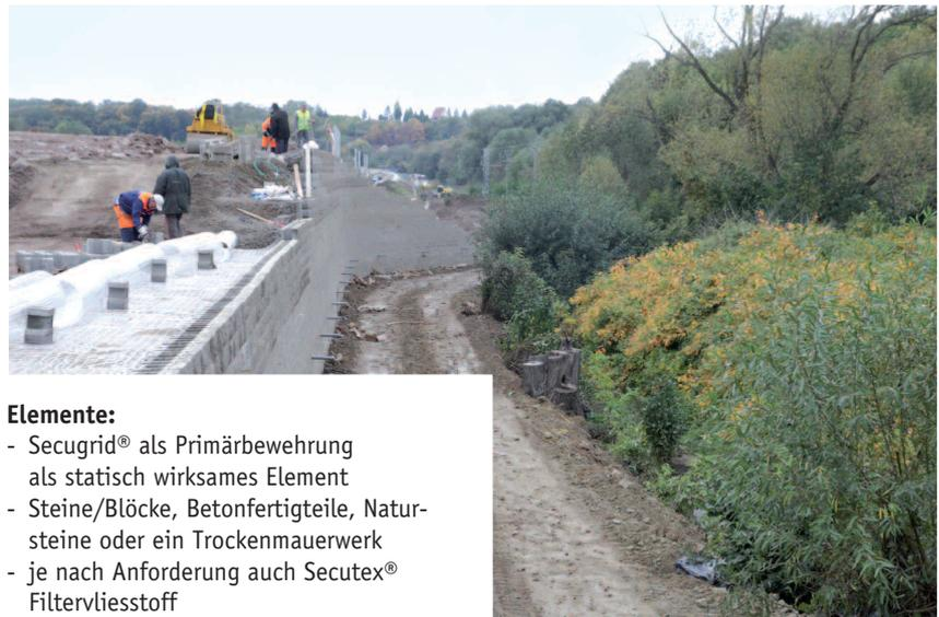
Eine gegebenenfalls erforderliche Dränageschicht zur Entwässerung der Konstruktion hinter den Blocksteinen, kann mittels eines Secutex® Filtervliesstoffes sicher und dauerhaft vom verwendeten Füllmaterial getrennt werden.
