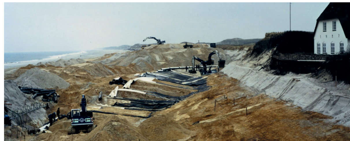
Abb. 2 Einbau der Sandpolster
