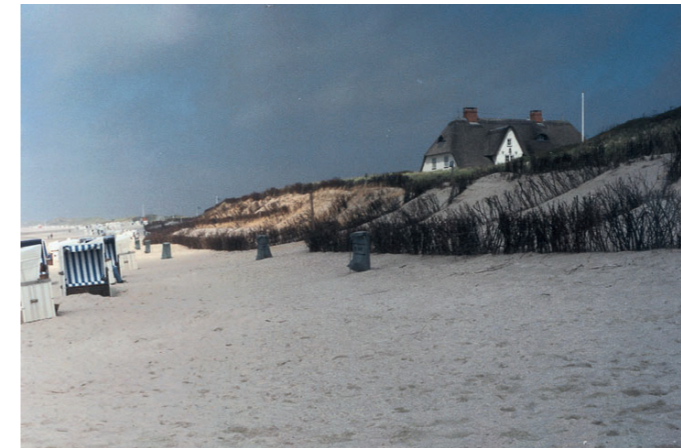
Abb. 3 Objektschutzbauwerk mit Sand abgedeckt und bepflanzt
