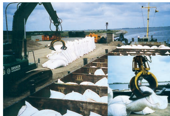
Bild 9. Kolkstabilisierung am Eidersperrwerk (1993): Verladung auf Steinstürzer (220 Stück pro Ladung). Fig. 9. Scour stabilisation to the Eider flood barrier (1993): Loading the rock dumper vessel (220 per load).
