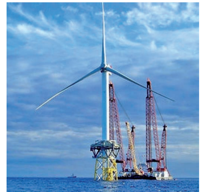
Bild 3. REpower 5M auf „alpha ventus“ installiert. Fig. 3. REpower 5M installed on „alpha ventus“.
