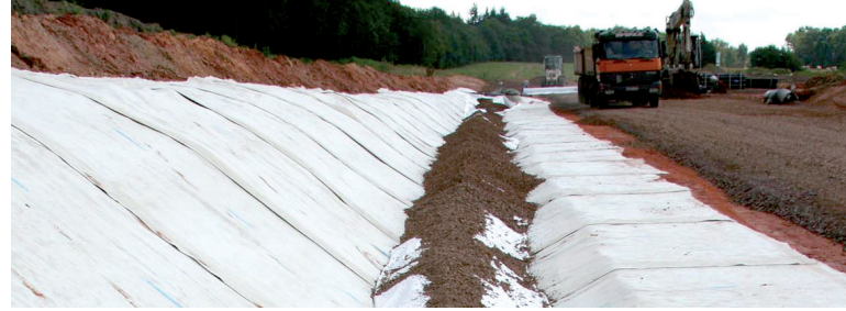
Abb. 2 Eingebaute Bentofix®-GTD als Umweltschutzmaßnahme unter einer Straße
