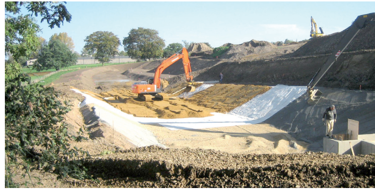
Abb. 11 Bodenaufbringung auf Bentofix®
