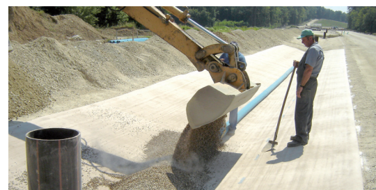
Abb. 15 Aufbringung des Bodens auf Bentofix®
