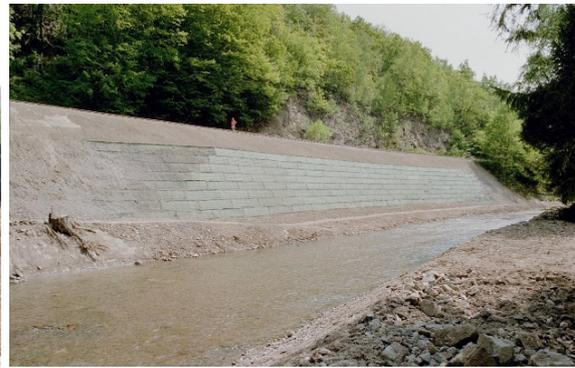
Abb. 16: Sanierungslösung mittels Kunststoff-Bewehrte-Erde-Konstruktion
