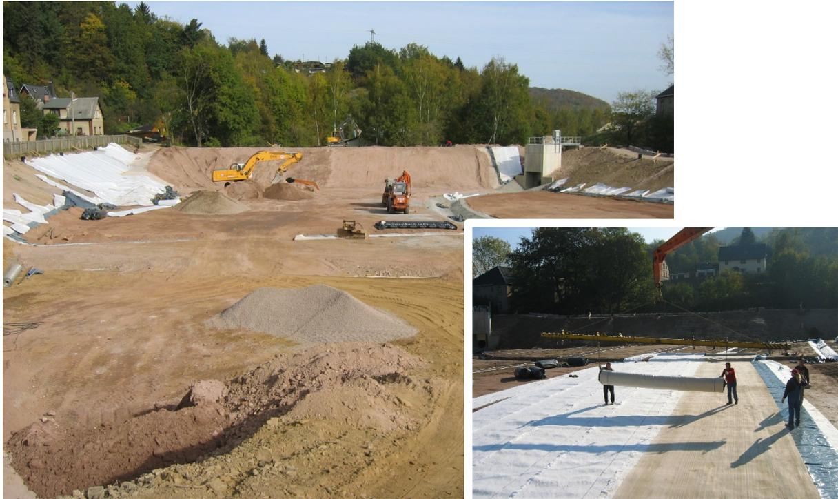
Abb. 31: Ausführung eines Rückhalteraumes infolge der Hochwasser 2002 an der Schlema, Zulauf zur Zwickauer Mulde, Abdichtung mit beschichteter geosynthetischer Tondichtungsbahn Bentofix® BFG 5000 und Überspannung von einbruchgefährdeten Bereichen durch Secugrid®
