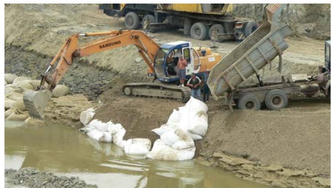
Abb. 29: Systemskizze einer Kolkschutzlösung mit geotextilen Sandcontainern bzw. Einbau robuster Sandcontainereinheiten (für temporäre Anwendungen auch aus biologisch abbaubaren Vliesstoffen)
