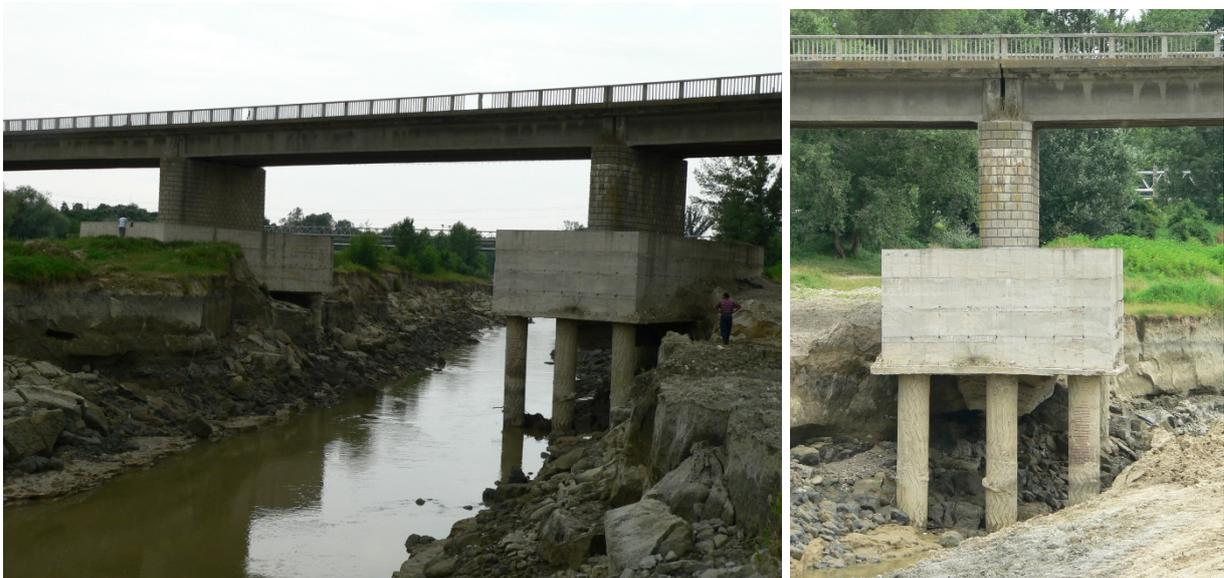
Abb. 27 und 28: Kolk Schäden an Brückenwiderlagern an einem Fließgewässer in Rumänien
