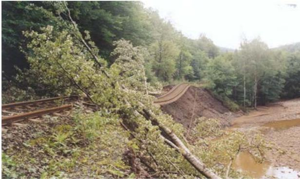
Abb. 15: Bahntrasse Weesenstein, 2002, Schadensbild durch Erosion
