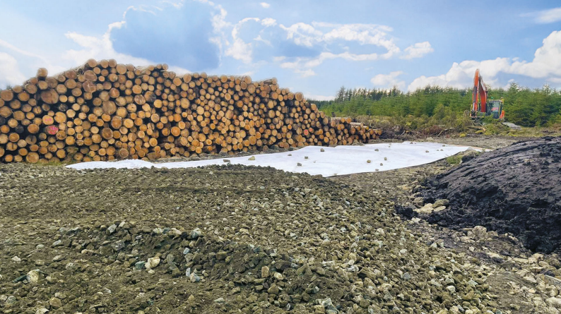
Abb. 2: Einbau von Combigrid®
