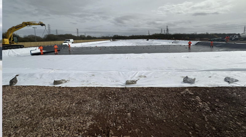
Abb. 2: Einbau von undurchlässigen isolierbaren Zellen mit Carbofol® und Secutex®
