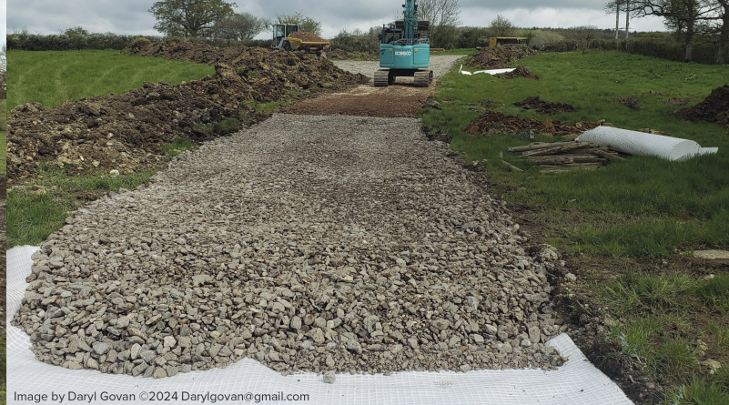
Abb. 2: Einbau Tragschichtmaterial auf Combigrid® (Zufahrtsstraße)
