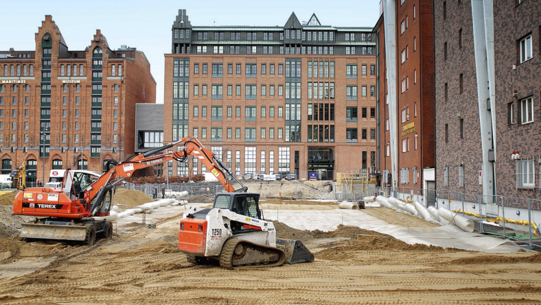
Abb. 1: Einbau von Secugrid® im Lastverteilungspolster
