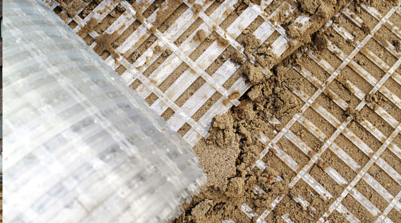
Abb. 2: Naue Secugrid® in kreuzweiser Verlegung
