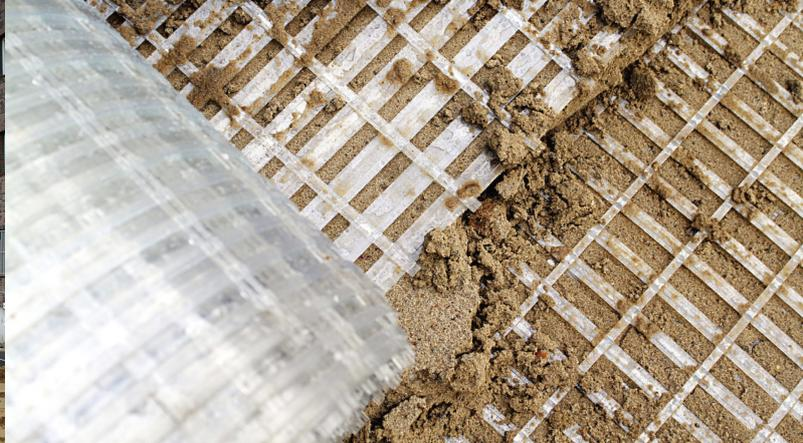
Abb. 2: Naue Secugrid® in kreuzweiser Verlegung
