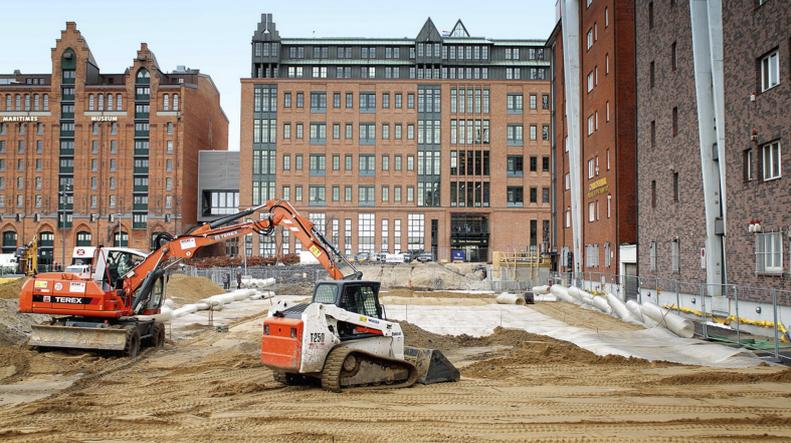
Abb. 1: Einbau von Secugrid® im Lastverteilungspolster
