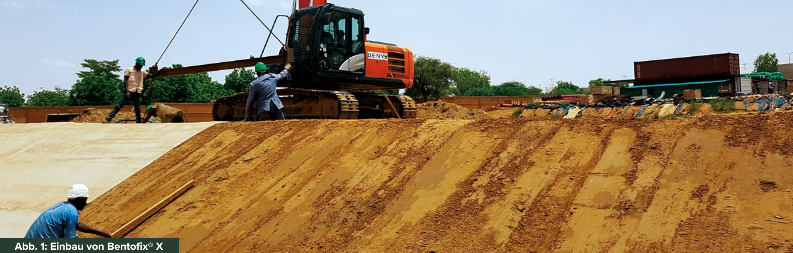
Abb. 1: Einbau von Bentofix® X
