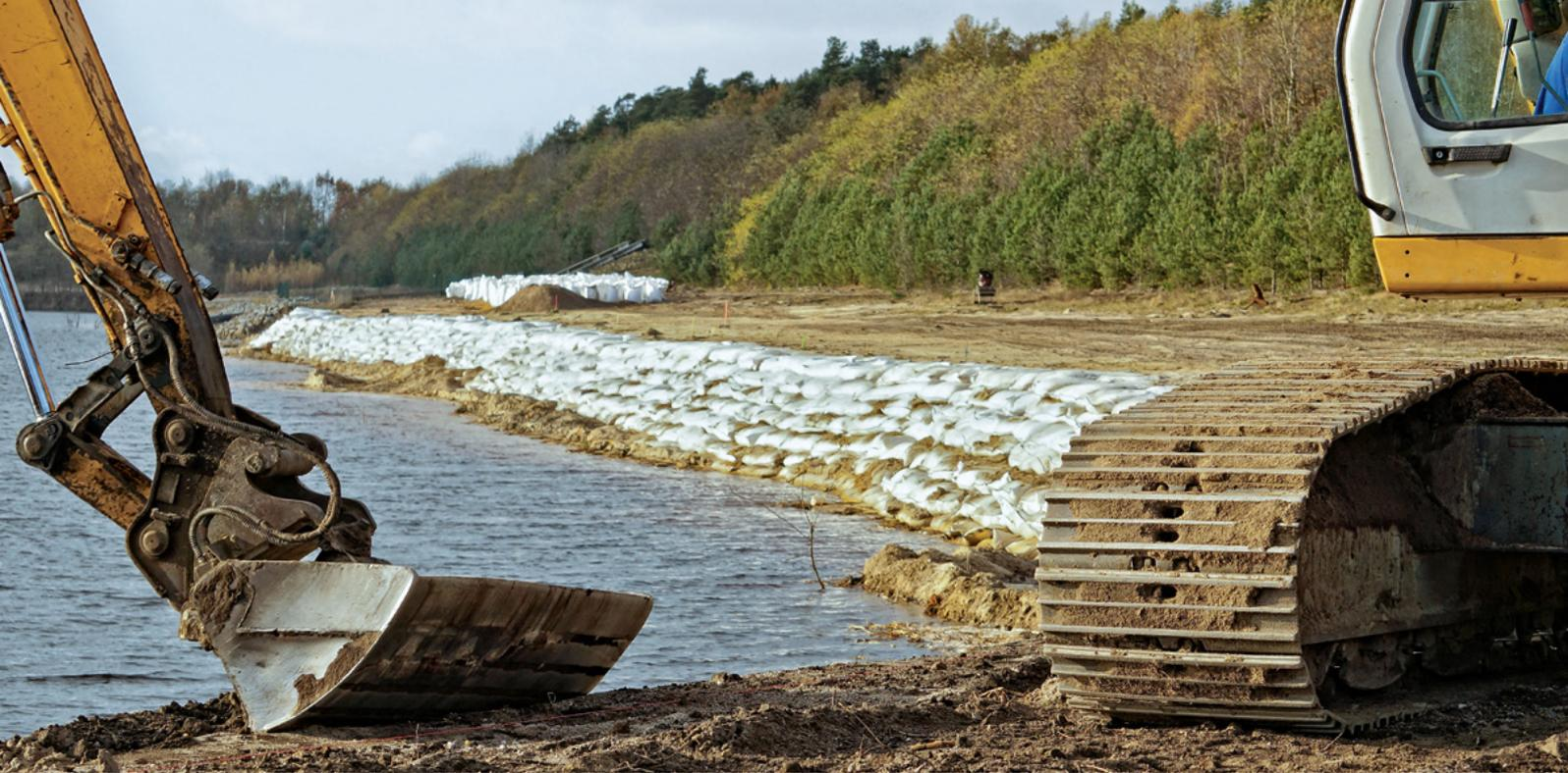
Dabei kommt die komplette Geokunststoff-Produktpalette zur Anwendung: Vliesstoffe, Kunststoffdichtungsbahnen, Geogitter, geosynthetische Tondichtungsbahnen, Drän-matten, sandverpackte Lösungen und mehr.
