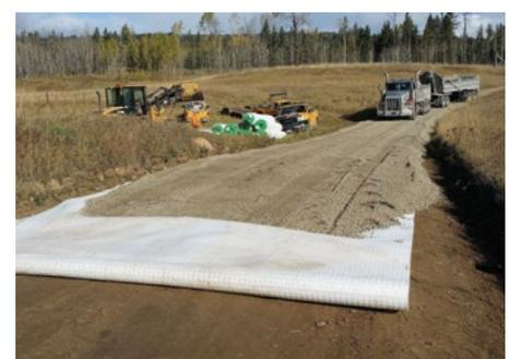
Abbildung 7: Einbau von Combigrid®
