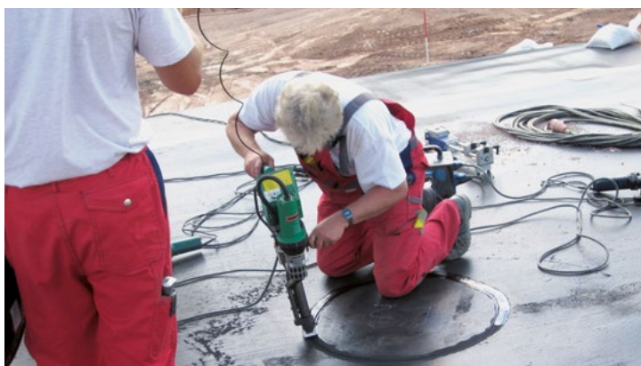
Abbildung 1 Schweißen auf der Baustelle wird durch eine hohe Melt-Flow-Rate begünstigt
