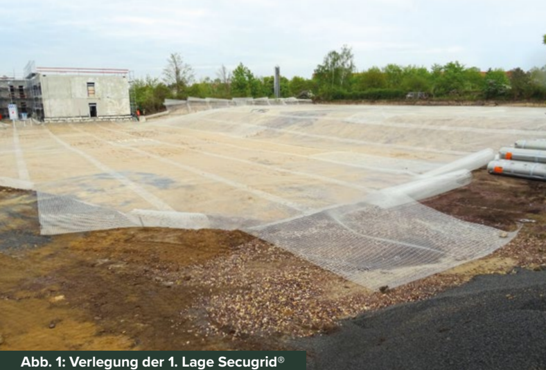
Abb. 1: Verlegung der 1. Lage Secugrid®
