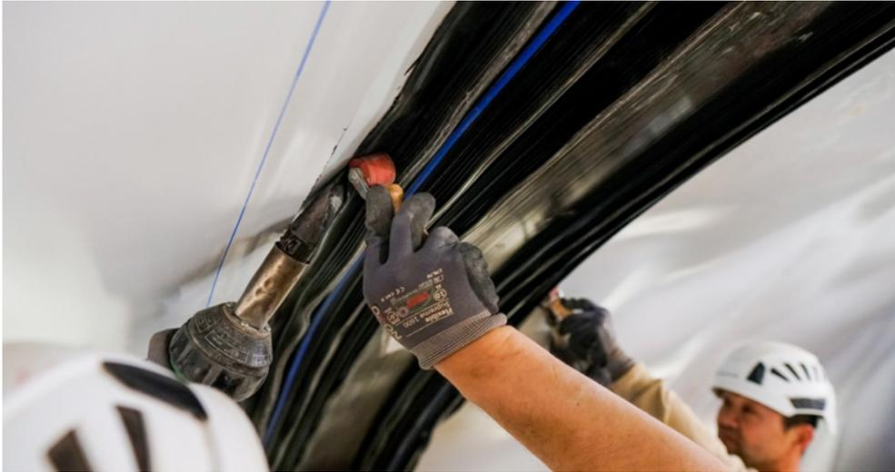
Abbildung 8: Einbau von Carbofol® Fugenbändern
