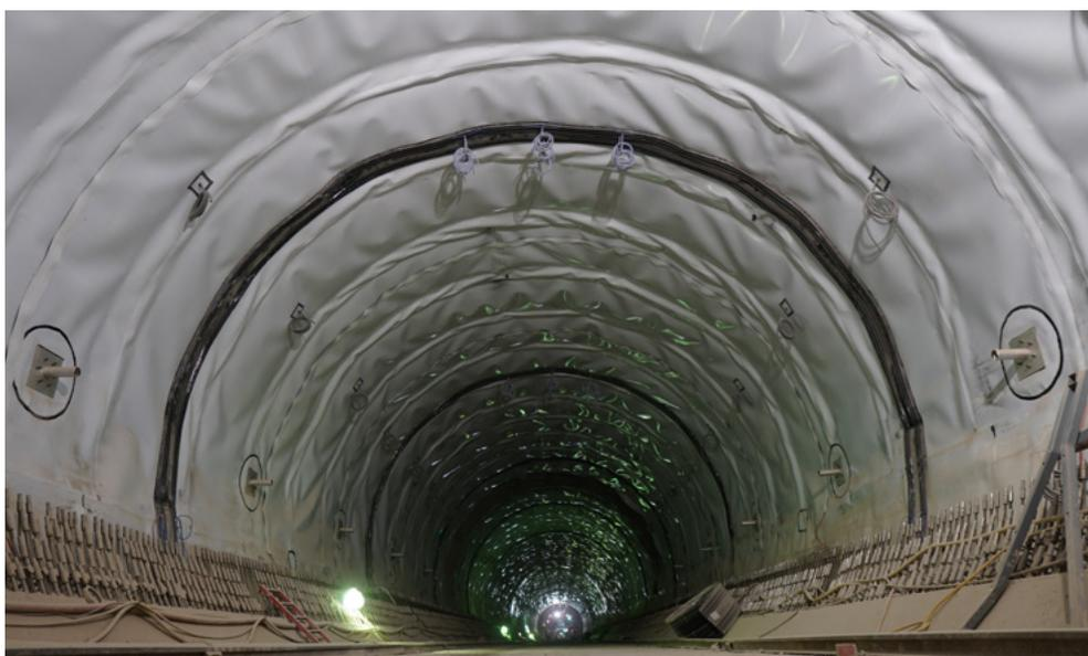
Abbildung 7: Entlüftungs- und Nachbetonierschläuche im Firstbereich
