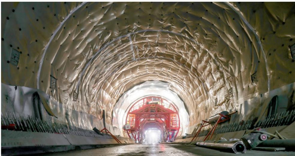
Abbildung 2: Bentofix® X Type im Gewölbebereich
