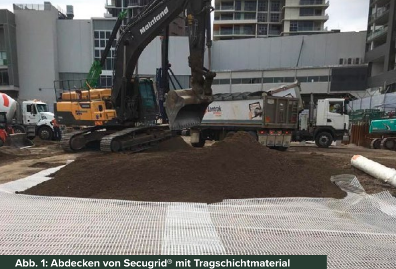
Abb. 1: Abdecken von Secugrid® mit Tragschichtmaterial
