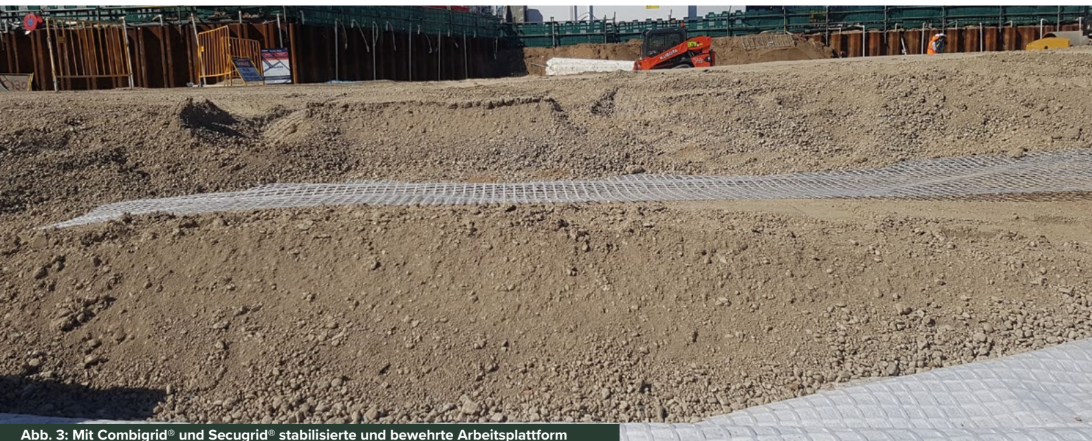
Abb. 3: Mit Combigrid® und Secugrid® stabilisierte und bewehrte Arbeitsplattform
