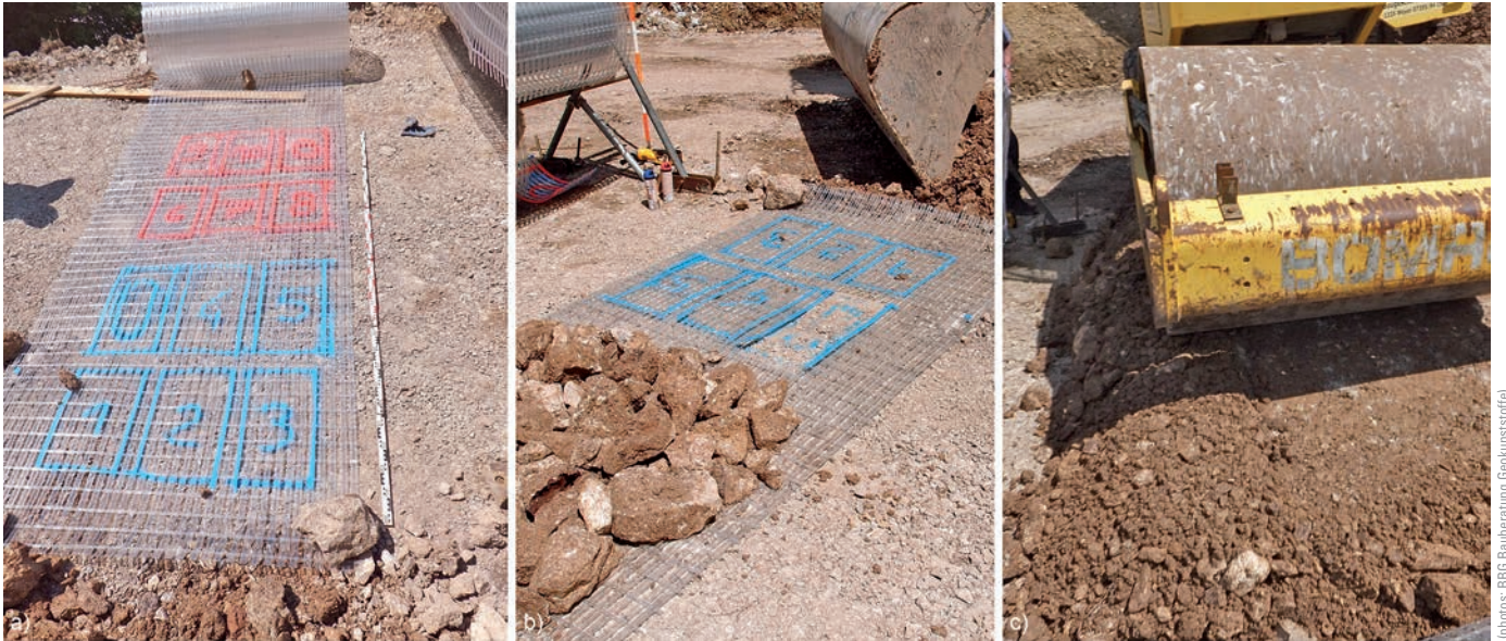
Fig. 7 Installation damage test using project-specific crushed stone as fill material: a) geogrid marked ; b) placing of stony fill; c) compaction Ausführung von Einbaubeschädigungsversuchen vor Ort mit der projektspezifischen Steinschüttung: a) Markierung der Probestücke; b) Platzierung der Steinschüttung; c) Verdichtung
